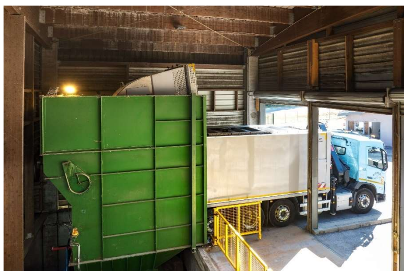
Les camions de collecte des conteneurs vident leur chargement aux quais de transfert. Les déchets y sont compactés dans des caissons fermés. Ceux-ci sont envoyés à Lons-le-Saunier pour y être traités.
