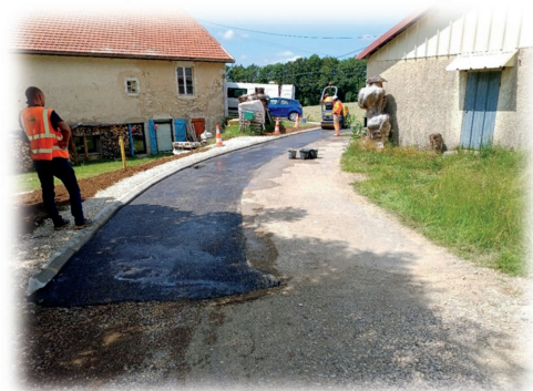
Travaux de voirie à la Chaîte
